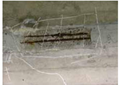
写真-4 剥離・鉄筋露出
